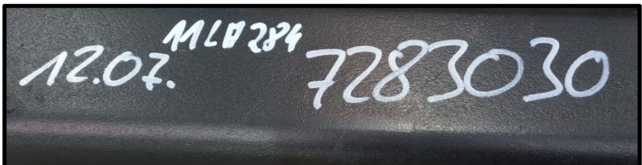
Abbildung 8 – Beschriftung mit DOLL-Artikelnummer auf Stahlbauteil mit weißem Edding
